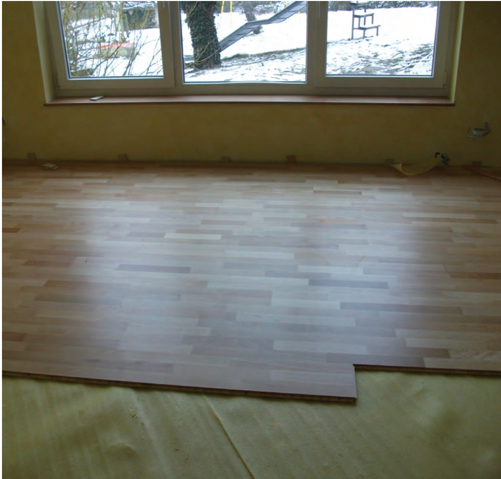
Untergrundvorbereitung und Verlegung von Massivholzparkett Buche
