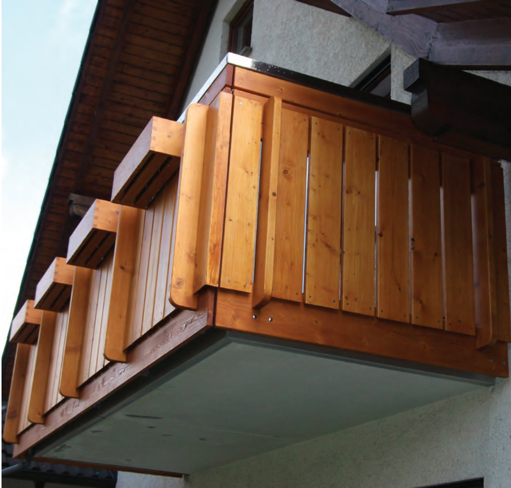
Balkonverkleidung aus Fichte massiv, lasiert
