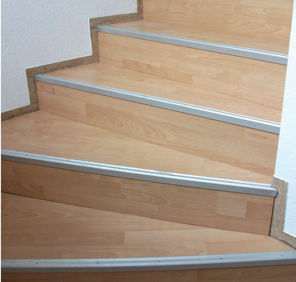
Betontreppe mit Laminat belegt
